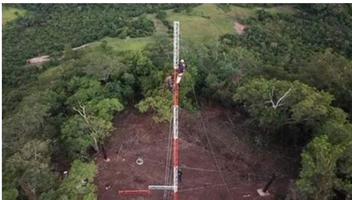
Figura 6 - Instalação de torre de transmissão
